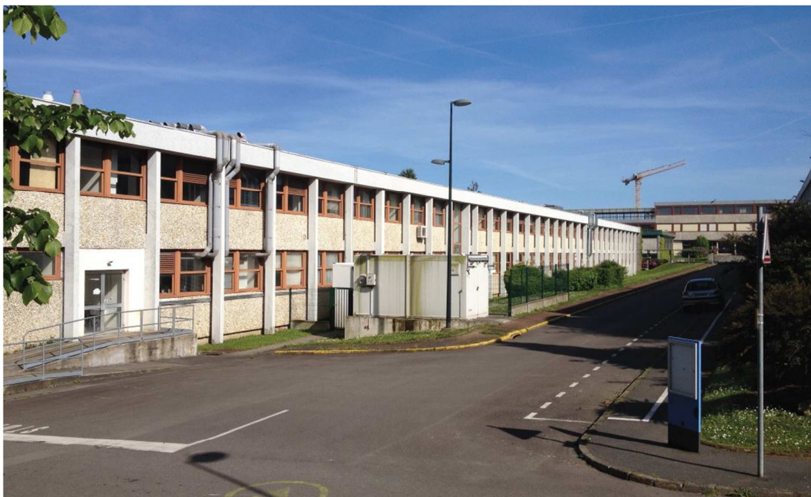
Projet réhabilitation bâtiment 4-LPGN – livraison mai 2018
